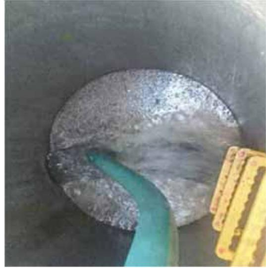
写真 7.2.(4) 吸引汚水のマンホールでの排水
