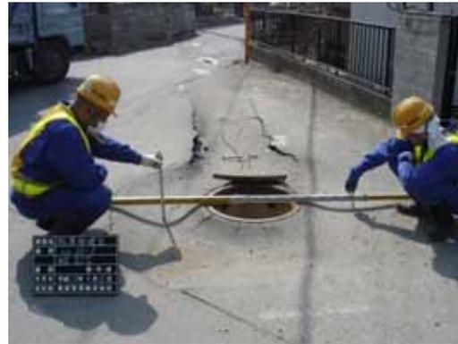
写真 1.5. (1) 液状化による被害の状況
