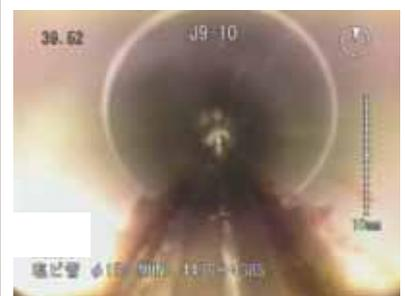
写真 8.6. (2) 下たるみ（管きよ沈下）の距離測定及び撮影例
