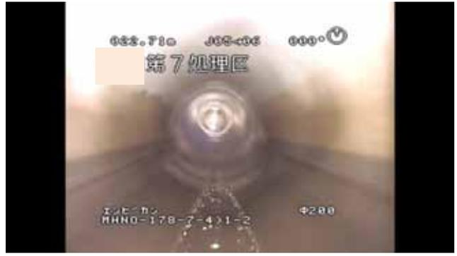
写真 8.6. (1) 上たるみ（管きよ浮上）の距離測定及び撮影例
