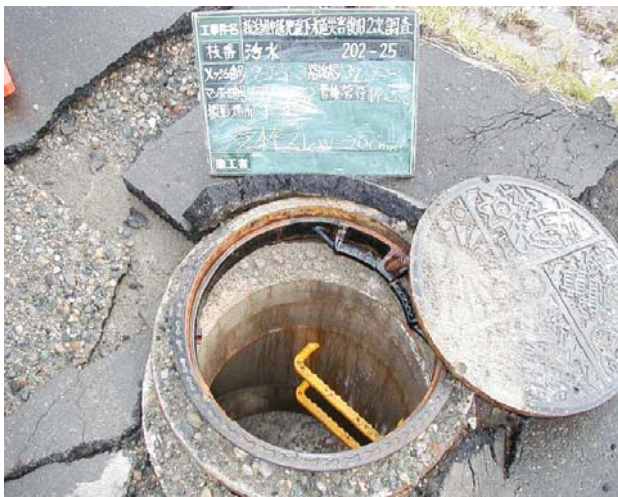
No.3 ふた受け枠のずれ
