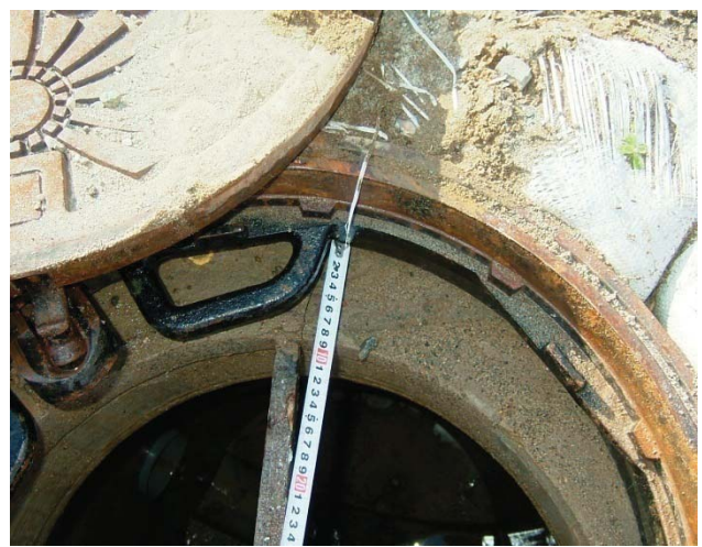
No.4 ふた受け枠のずれ
