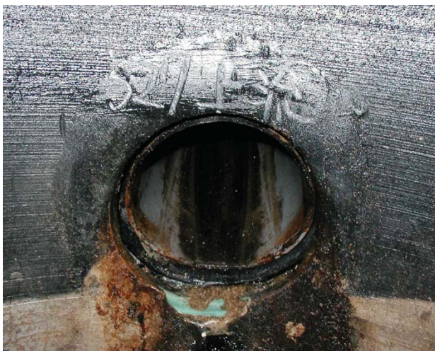
No.5 管口抜出し
